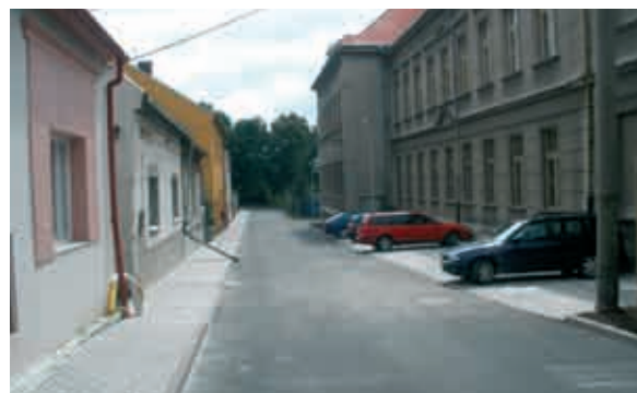
Nerudova ulice v novém kabátu – nové chodníky, nová komunikace, nové veřejné osvětlení a nové parkoviště
