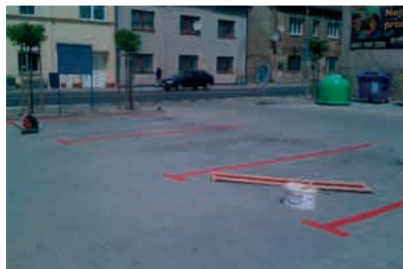
Úprava parkovacích míst na ploše k parkování na ulici Osecká – to kvůli neukázněným řidičům parkujícím nevhodně
