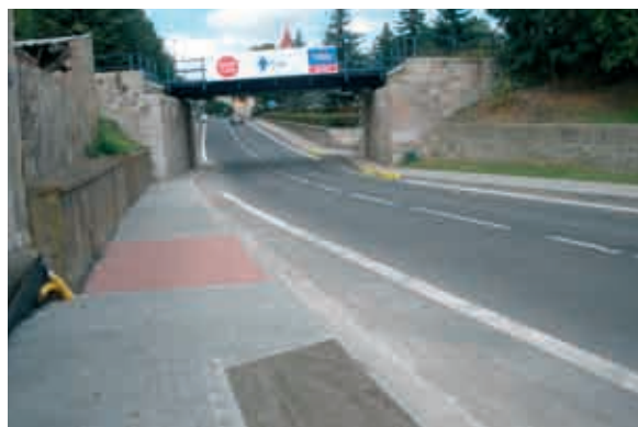
Rekonstrukce chodníků od nám. Republiky po ulici ČSA – zúžení a vytvoření zeleného pruhu, jenž bude osázen živým plotem, rekonstrukce VO
