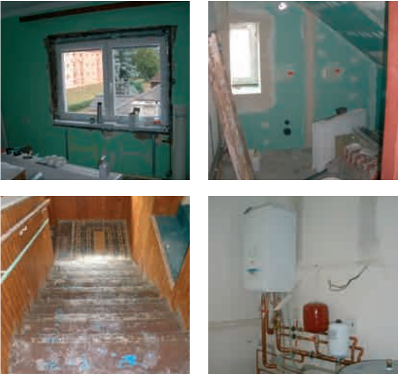
Rekonstrukce MŠ v Loučně v plném proudu – výměna zbytku starých oken, plynofikace a nový kotel s bojlerem, výměna krytiny, realizace nových sociálních zařízení v horním patře, malování...
