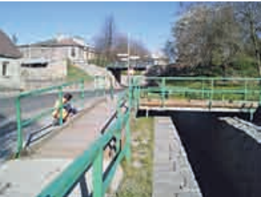
Opravy a nátěr zábradlí lávky přes potok v ulici ČSA
