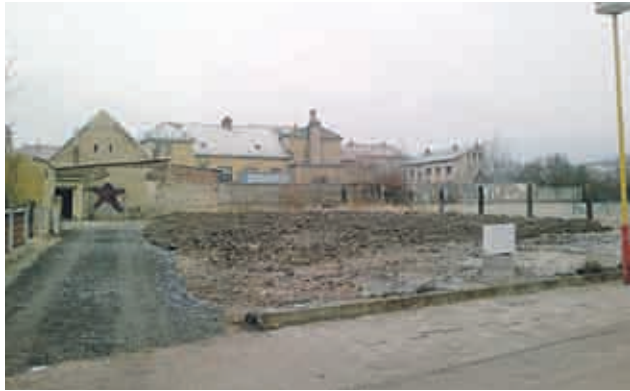
Demolice vyhořelého domu č.p. 410 v ulici Husova jak šel čas.
