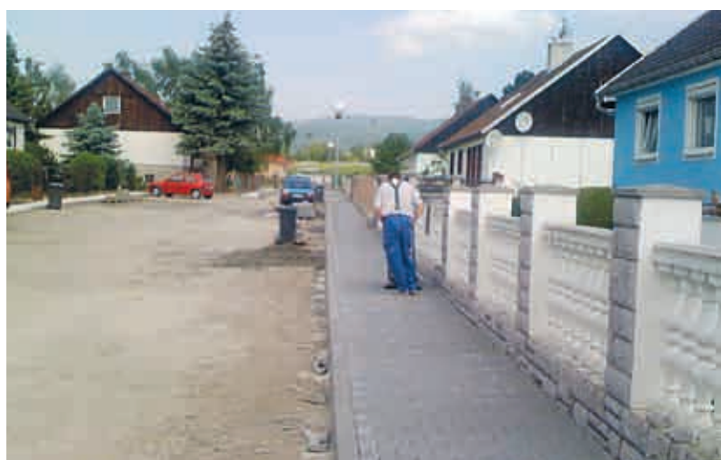
Chodníky a nové veřejné osvětlení na náměstí Republiky u okálů jsou již hotové, zbývá dodělat silnici.
