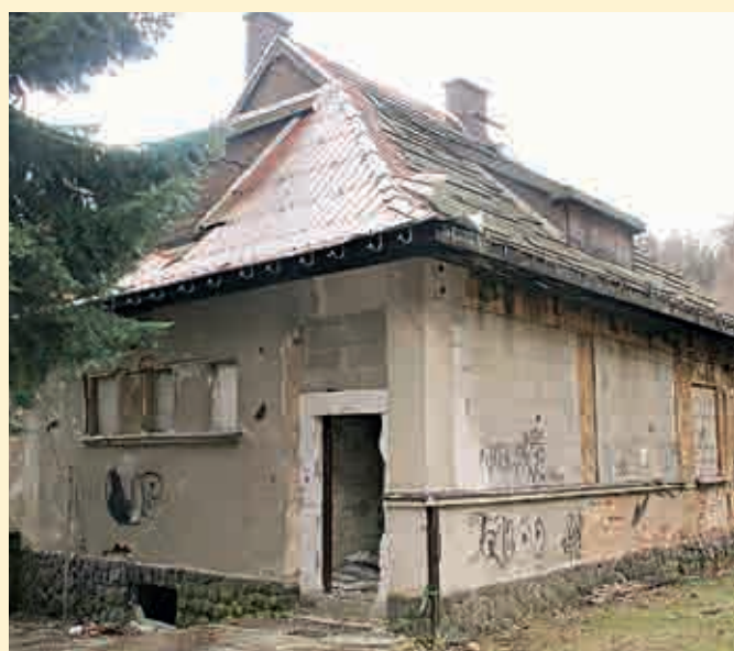
Jakékoli problémy v lese, stejně jako dotazy na hájovnu č.p. 705 (na snímku) či na svoz dřeva v ulici Lesní směrujte prosím na Ing. Aleše Kilba, nového lesního správce Lesní správy Litvínov, telefon 724 524 886.
