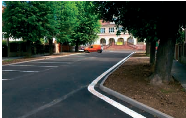
Rekonstrukce Havlíčkova náměstí
