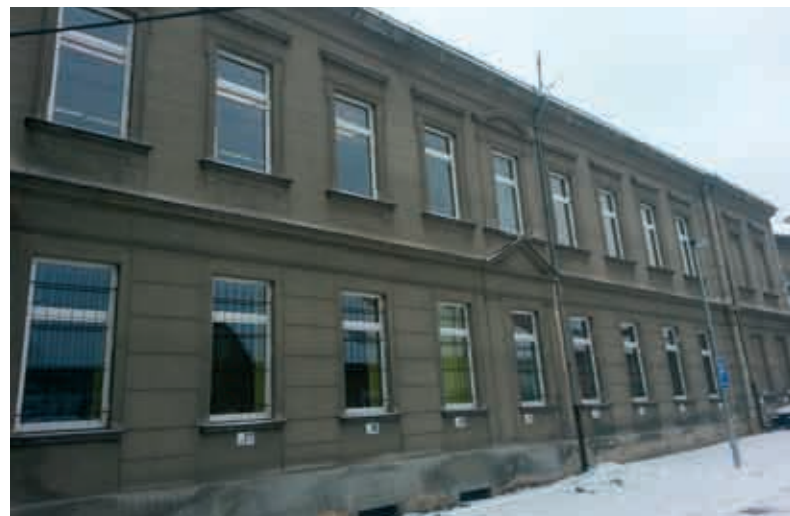
Výměna oken ZŠ Lom
