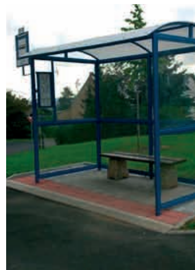
Autobusová čekárna v ul. Libkovičká
