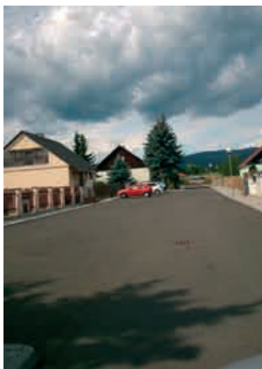
Rekonstrukce komunikace, okály, nám. Republiky
