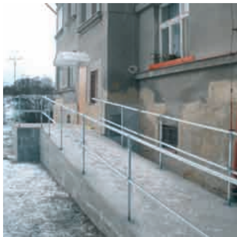
Senioři z Penzionu pro seniory v ulici ČSA č. p. 487 se konečně dočkali nájezdové rampy.
