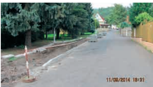
Rekonstrukce chodníku v ulici K Hájojně
