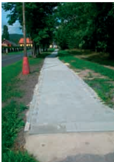
Konečně je mezi dolním a horním Lomem důstojná spojka
