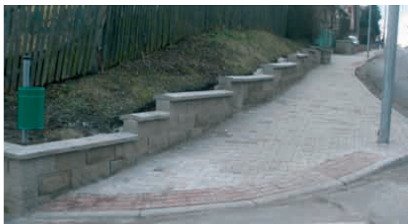
Chodník v ulici PKH směrem k bývalé restauraci Anetka a zbrusu nové osvětlení si tamní obyvatelé a nejen oni zasloužili. Vybudováním chodníku jsme zvýšili bezpečnost např. maminek a tatínek vodících děti do MŠ.
