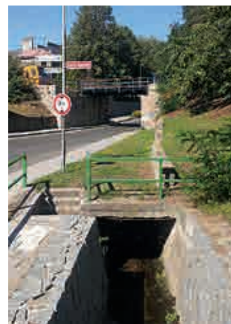
Po nezbytnou dobu bude přerušena doprava pod železničním viaduktem.
