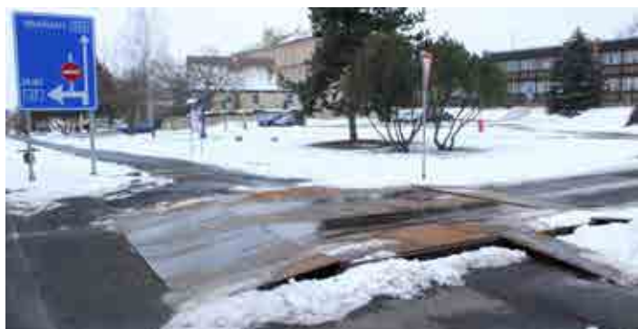
Kovový provizorní most umožňuje bezpečný průjezd vozidel a cyklistů i průchod pěších tímto místem na náměstí Republiky.
