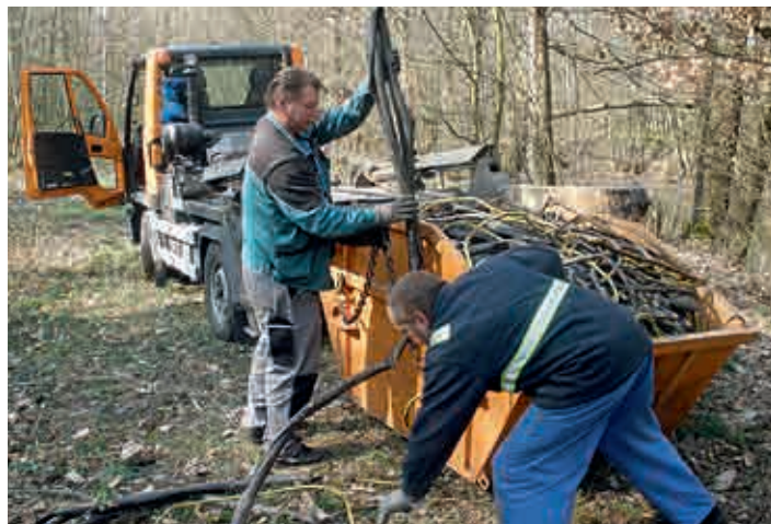
U Malého Oprámu bylo především velké množství izolací z kabelů.
