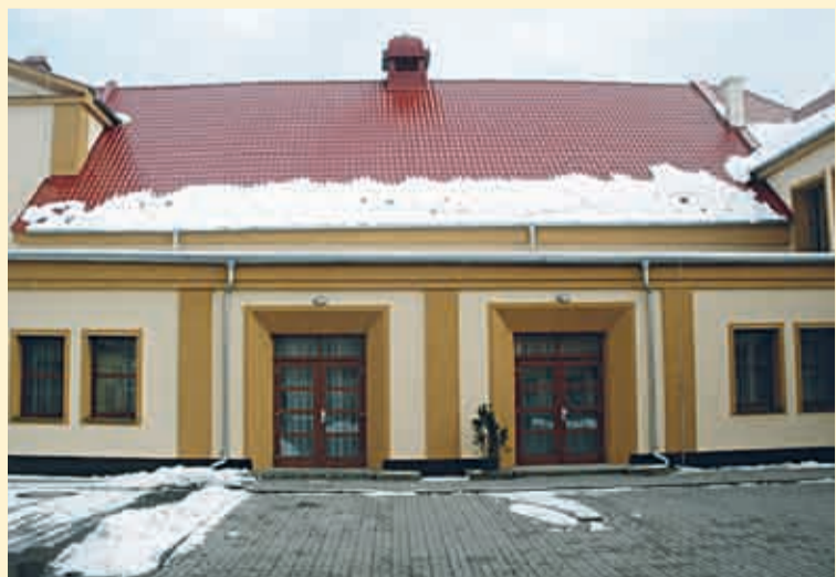
Požární zbrojnice a kulturní dům si nový plášť již zasloužily...
