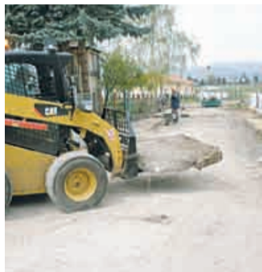
Rekonstrukce chodníků a komunikace na náměstí Republiky u okálů
